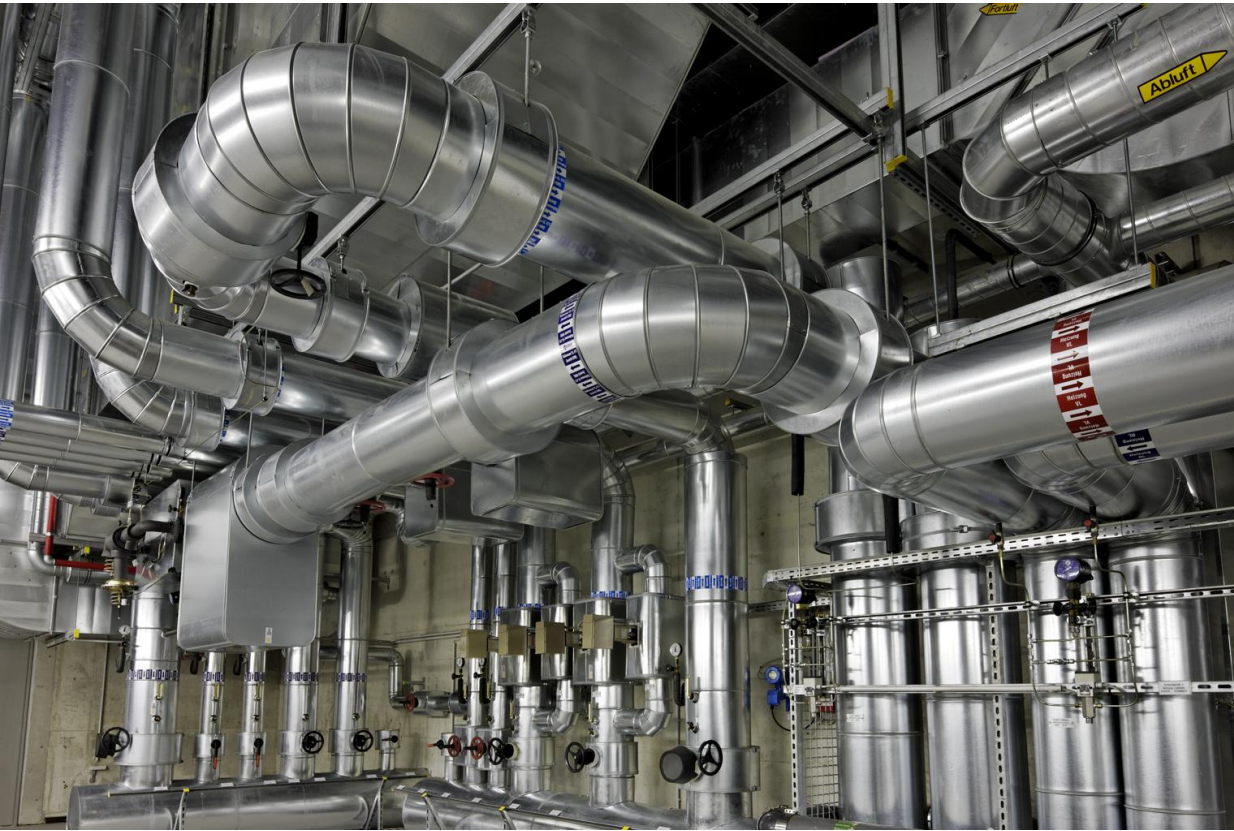
Kälteverteiler
